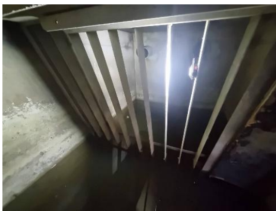
รูปที่ 2-44 จัดให้มีตะแกรงดักขยะก่อนระบายน้ำออกจากโครงการ
