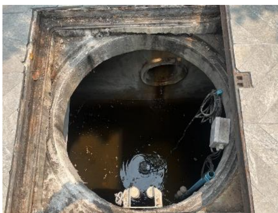
รูปที่ 2-43 จัดให้มีการตรวจสอบระดับน้ำในบ่อพัก และท่อระบายน้ำ
