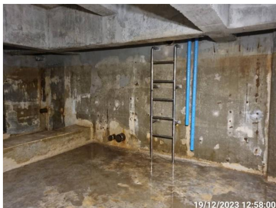
รูปที่ 2-57 การล้างถังเก็บน้ำใช้ ประจำปี 2566
