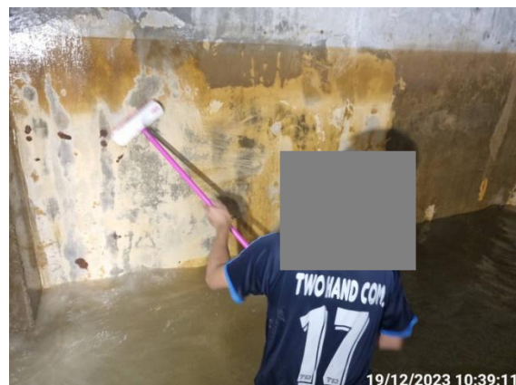
รูปที่ 2-57 การล้างถังเก็บน้ำใช้ ประจำปี 2566
